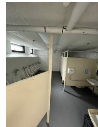
P1. Basement toilet room
